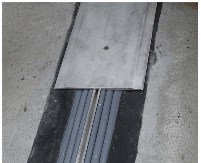
Sistema SJS instalado con material de reborde elastomérico EMCRETE en muescas a cada lado de la junta.
