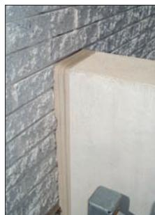
*SEISMIC COLORSEAL es una solución ideal para sustratos texturizados o ásperos. La naturaleza flexible del producto, combinada con su contrapresión inherente permite para adaptarse a la superficie de la pared*
