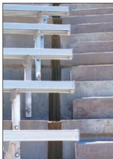
*La impermeabilización de juntas de dilatación en un estadio se muestra aquí en un concreto prefabricado. DSM ofrece continuidad de sello a través de cambios de plano y dirección.*
