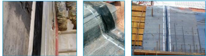
*Una vez que el sistema de BG está instalado a la losa de barro o atraso, se echa hormigón para encapsular la membrana impermeabilizante y el BG, lo que resulta en un sistema integrado impermeable que acomoda movimiento en la abertura de la junta.*
