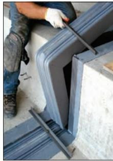
*EMSEAL ofrece transiciones prefabricadas en factoría para huellas y contrahuellas que permiten facilidad de instalación y garantizan la impermeabilidad en los cambios de plano.*
