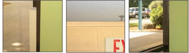
QuietJoint llena con facilidad aberturas y las juntas entre las particiones, paredes y ventanas, fin de las paredes, y en otros lugares sin movimiento.
