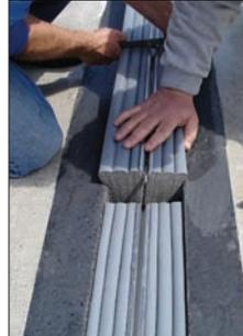
*La contrapresión de la espuma SJS y un adhesivo epoxi proporciona impermeabilidad sin anclaje invasivo sin depender de una canaleta. La instalación es más rápida que otros sistemas más complicados.*
