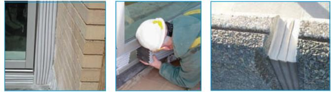
SEISMIC COLORSEAL DS sella lados interiores y exteriores de juntas de pared de cortina en un solo paso de instalación. Cada lado puede tener su propio color a juego con el interior y combinaciones de colores exteriores. Para parapetos puede proporcionar una superior, frontal y posterior superficie sellada abarcando los tres planos expuestos.
