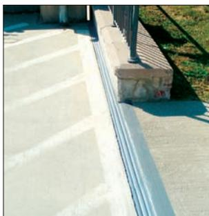
La tecnología del sistema DSM proporciona una solución de sellante de junta estructural. Aquí DSM está instalado en la parte superior de una rampa donde una unidad de transición de carril de el grado de losa de apoyo y de piso a piso a pared.
