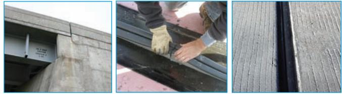
Desde identificar el problema estructural en una nueva o antigua junta de dilatación hasta la instalación, el sistema BEJS ofrece una solución rápida y duradera y asequible. Proporciona un sello continuo a través de carreteras, bordillos, aceras y parapetos.
