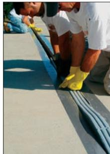
*DSM ofrece una instalación fácil. Después que se ha aplicado epoxi al sustrato los listones de DSM son empujados dentro de la junta. Listones contiguos son alineados a la cara del ya instalado y se mantienen por encima de la superficie hasta que el adyacente listón es metido en la junta.*
