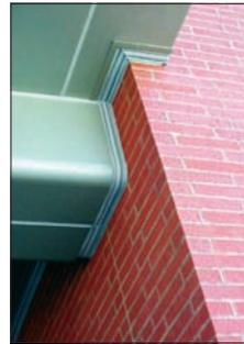
*SEISMIC COLORSEAL instalado en un edificio de fachada entre materiales disímiles mantiene el valor R en el entorno del edificio. Como SEISMIS COLORSEAL no usa sujetadores es especialmente adecuado para el llenado de uniones en las esquinas interiores.*
