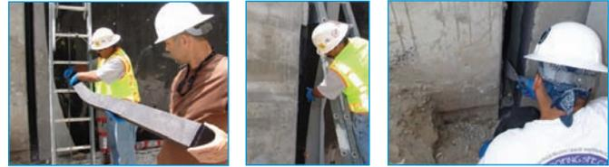
El sistema de 20H se instala desde el lado positivo de la pared de retención en una abertura de la junta preformada en concreto curado.
